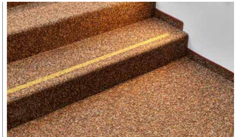
Gele strepen van Kugelgarn® Graffiti ginster (brem) zorgen voor veiligheid op de traptreden.
